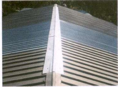
Foto 2: Sustitución de capote y elementos de fijación. (Aula 1)
