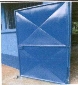
Foto 5: Sustitución de chapa (Puerta 1)
