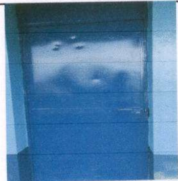
Foto 6: Sustitución de chapa (Puerta 2)
