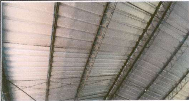
Foto 1: Sustitución de lamina troquelada aluzinc Calibre 26. (Aula 2)
