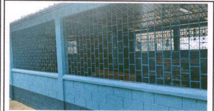
Foto 9: Sustitución de balcones de metal
