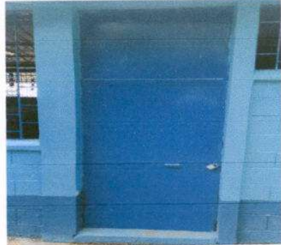
Foto 4: Sustitución de puerta
