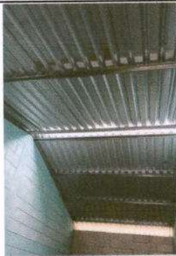
Foto 3: Sustitución de estructura de soporte de madera por metal (Bodega)
