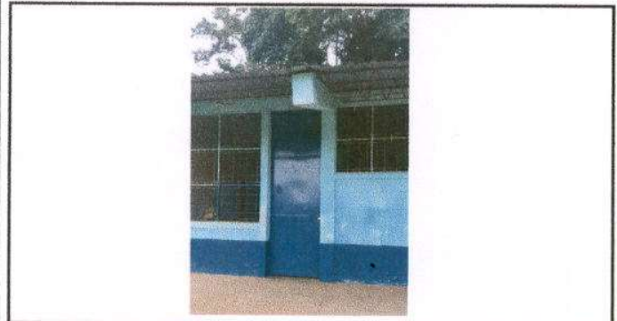
Foto 11: Sustitución de balcones de metal
