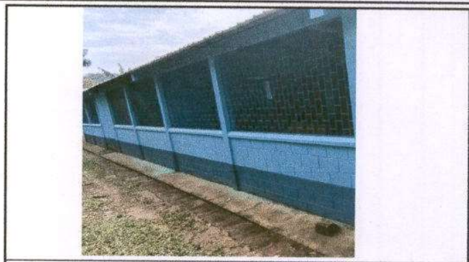
Foto 8: Sustitución de balcones de metal
