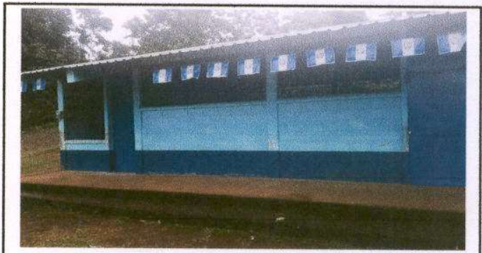
Foto 10: Sustitución de balcones de metal
